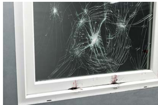
Glasaustausch und Fensterreparatur
